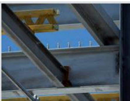
acél szerkezet építés
